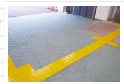
ピロティ 改修後
